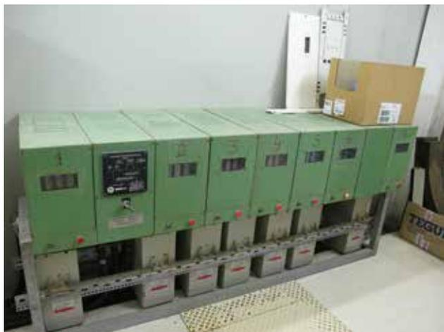
**Figura 22.** Baterias de condensadores
