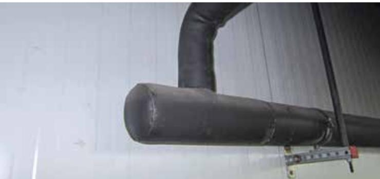
**Figura 20.** Isolamento de tubagens em boas condições.
