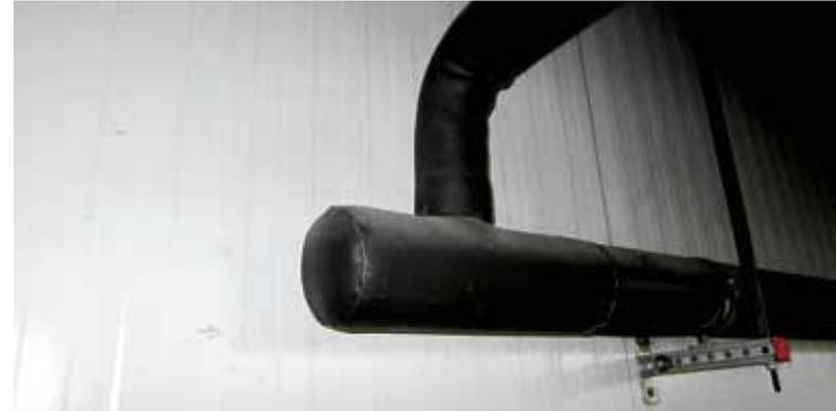
**Figura 12.** Aislamiento de tuberías en buenas condiciones.
