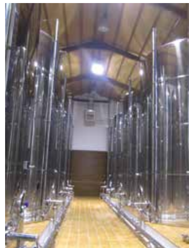
Figura 10. Serbatoi in acciaio per la conservazione dell'olio di oliva.
