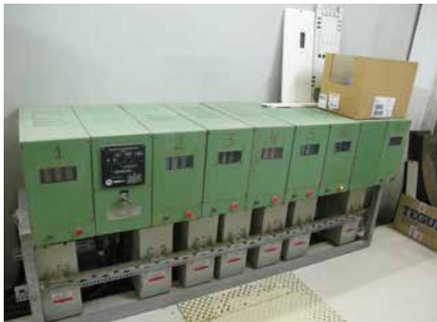
Figure 22. Batteries de condensateur.
