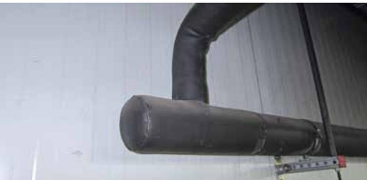
**Figure 20.** Bonnes conditions d'isolation des canalisations.
