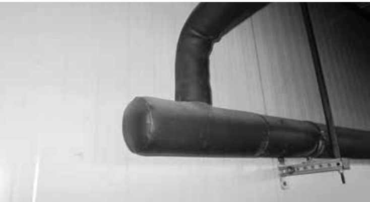
Figura 16. Isolamento de tubagens em boas condições.
