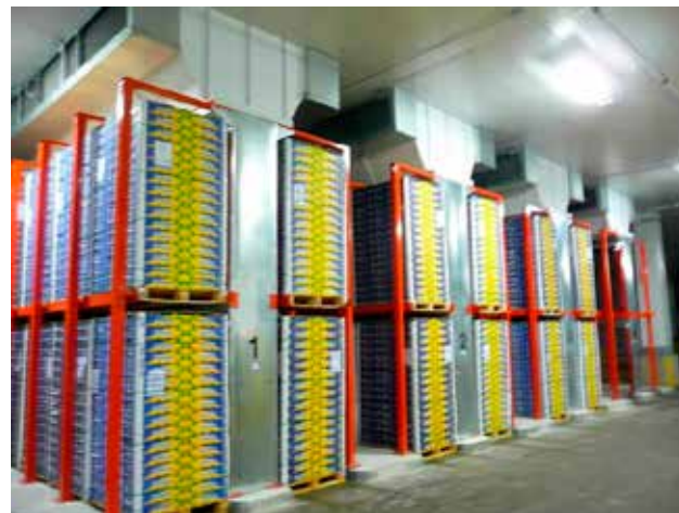
Figura 4. Pré-refrigeradores verticais de fluxo de ar reduzem o tempo de pré-refrigeração, o que aumenta a qualidade e a vida útil dos produtos e permite poupar nos custos de energia.
