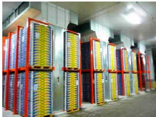
**Figure 4.** Refroidisseurs verticaux réduisant le temps de pré-refroidissement, (augmentation de la durée de vie et la qualité les fruits et légumes, économies d'énergie).
