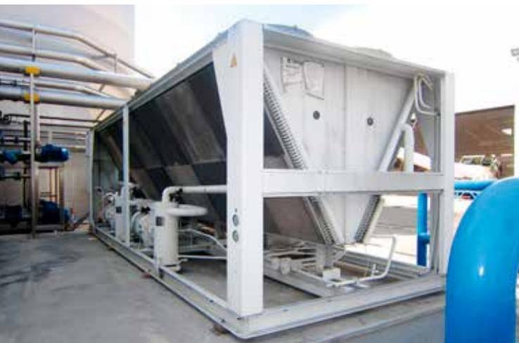
Figure 12. Machine frigorifique.
