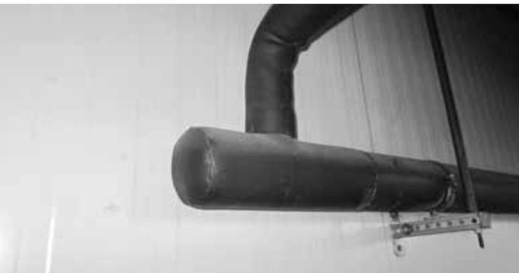
**Figure 16.** Bonnes conditions d'isolation des canalisations.
